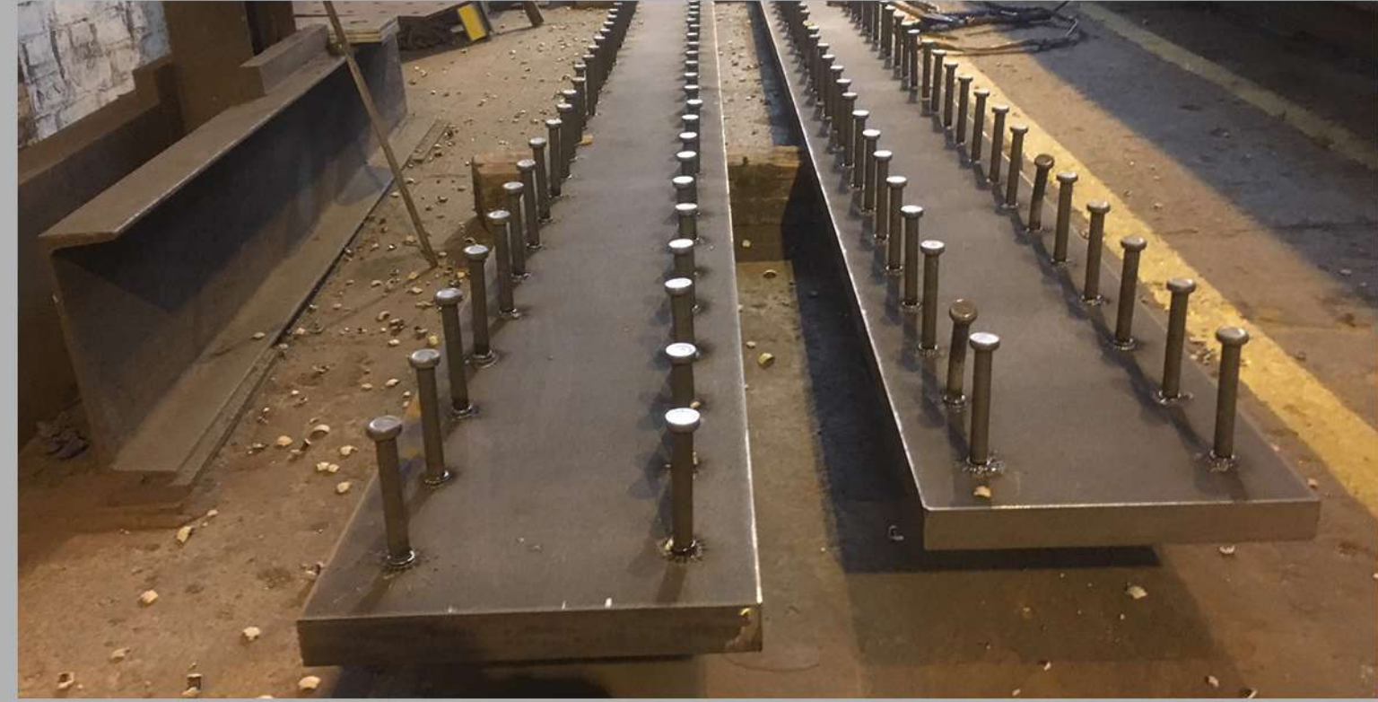
SHEAR STUD WELDING
